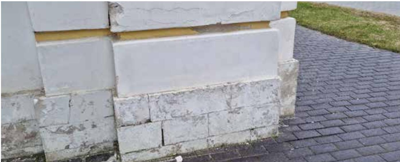
Фото 4. Состояние цоколя в процессе эксплуатации.
