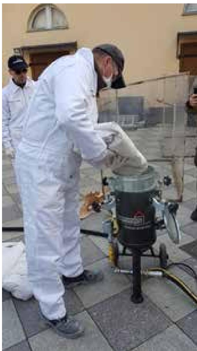
Фото 7. Очистка цоколя струйно-вихревым методом rotec®.
