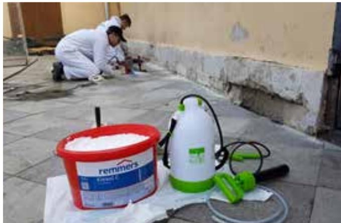
Фото 10. Устройство отсечной гидроизоляции. 2019 г.
