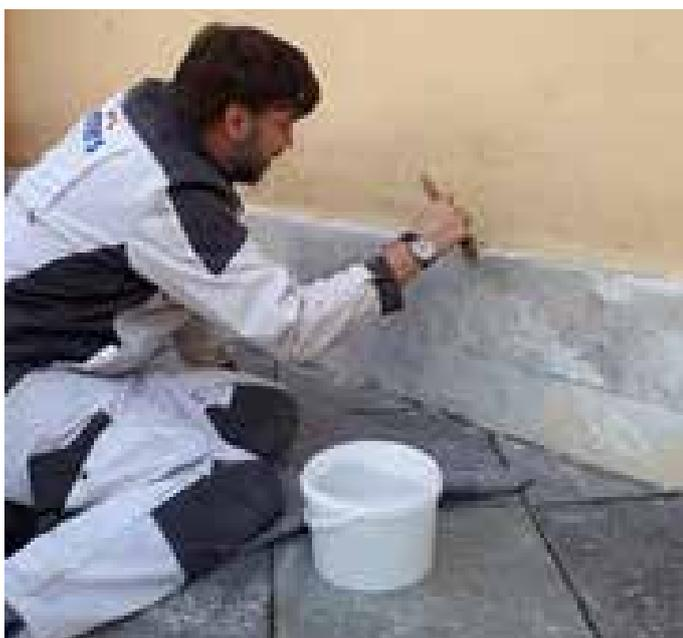
Фото 18. Нанесение лессирующего покрытия AvenaLasur Silicone. 2023 г.
