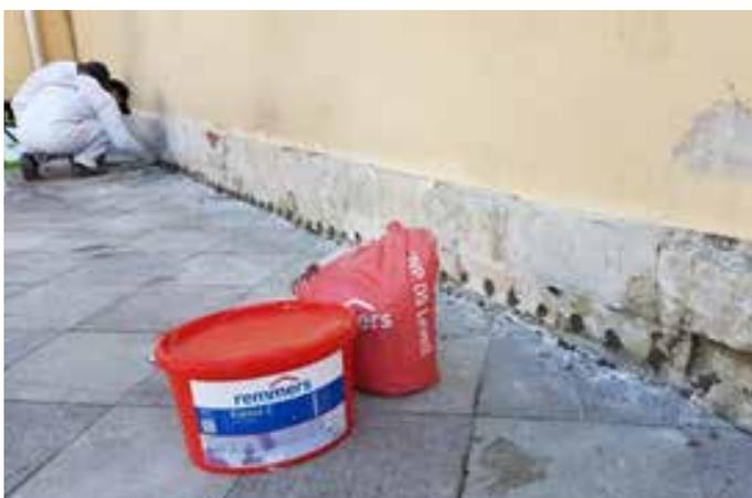
Фото 9. Устройство отсечной гидроизоляции. 2019 г.
