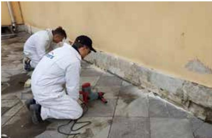
Фото 8. Устройство отсечной гидроизоляции. 2019 г.
