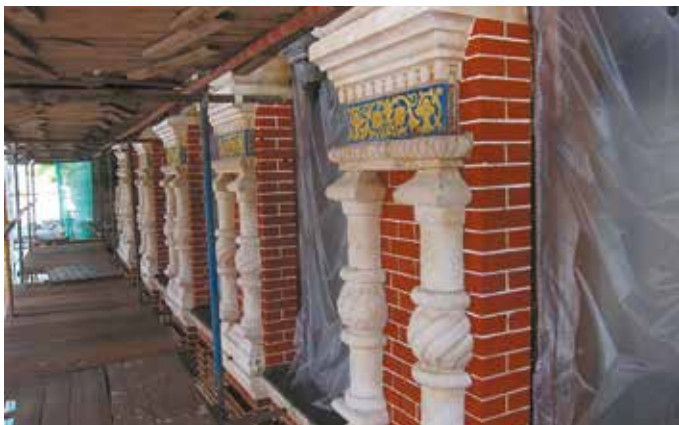
Фото 2. Дом Игумнова на Якиманке. Восстановление кирпичной кладки и декоративных элементов.
