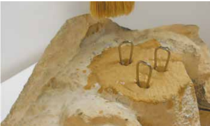
Фото 13. Lithos Arte®. Нанесение грунтовки.
