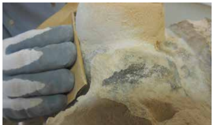
Фото 18. Lithos Arte®. Лёгкая шлифовка поверхности для достижения финишного цветового оттенка и фактуры.
