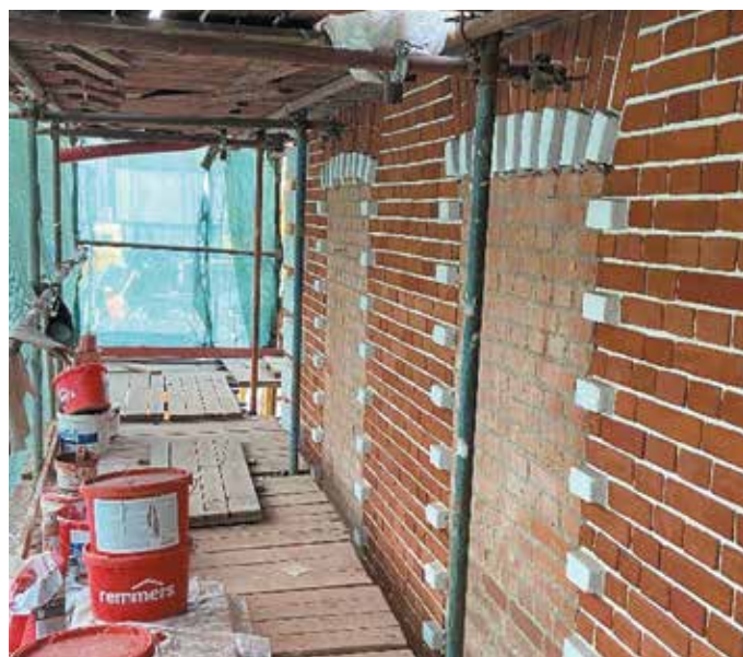
Фото 6. Детская больница Святой Ольги. Выполненный участок работ.
