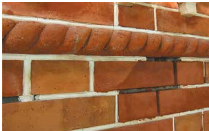
Фото 3. Дом Игумнова на Якиманке. Восстановление кирпичной кладки и декоративных элементов.
